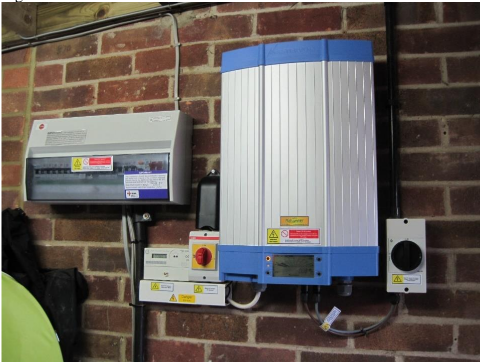
Figura 11: Inversor fotovoltaico.
