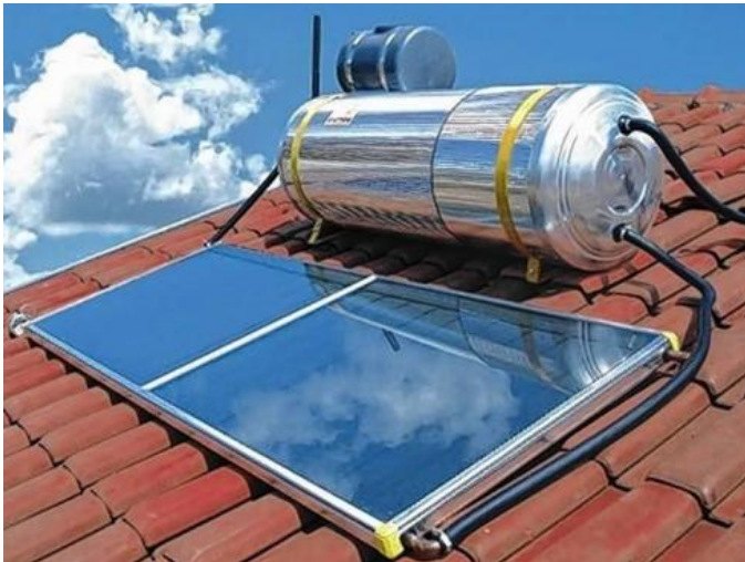
Figura 7: Sistema de aquecimento solar de água
