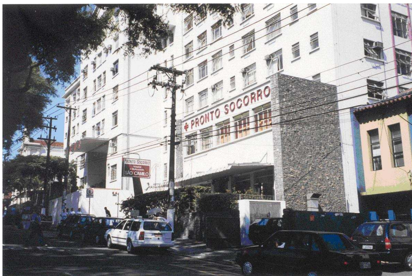
Figura 18: Antiga fachada do Hospital e Pronto Socorro Fonte: Acervo da Gestão de Marketing e Comunicação, 2009.
